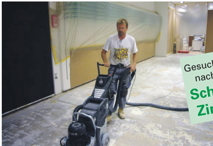
Untergrund-Schleifarbeiten
